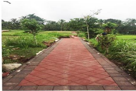
Peningkatan Jalan Lingkungan Permukiman Desa Carangsari Kec. PETANG
